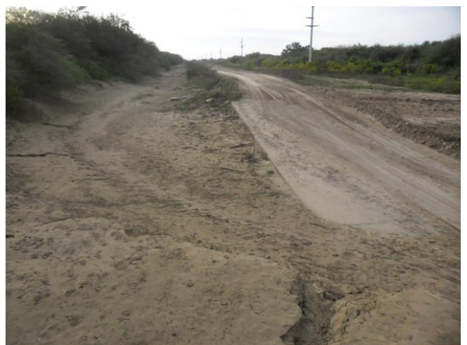
Badén de Hormgión en la ruta Zona de cruce de agua en crecientes.
