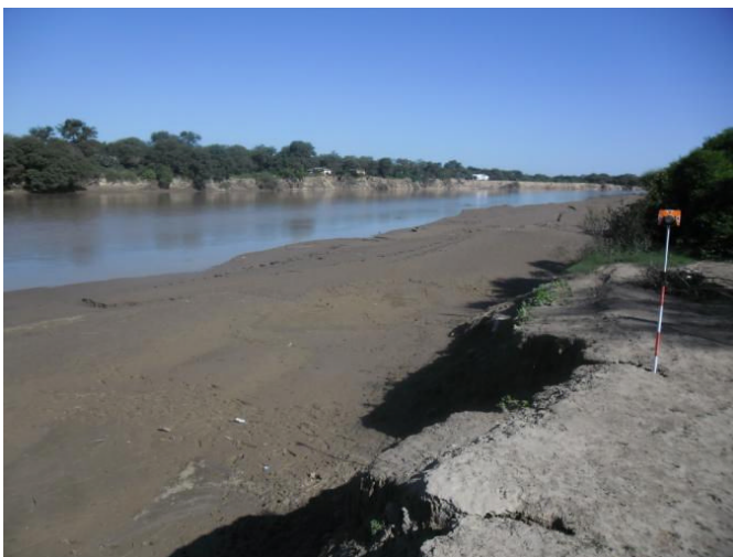
Prog. 0+140 m, margen paraguaya Vista hacia aguas arriba
