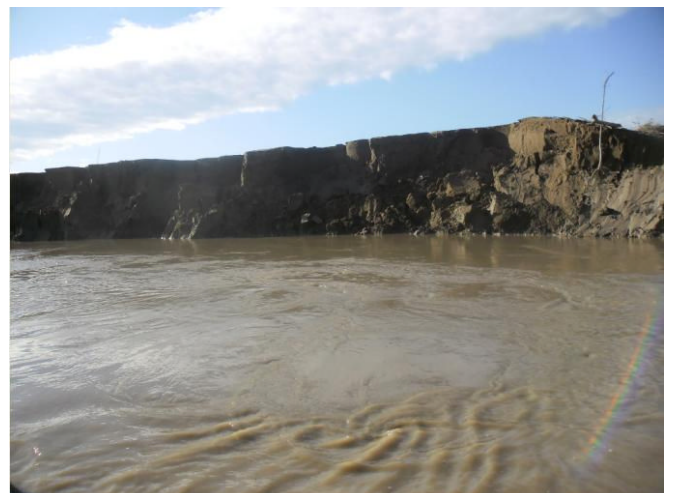
Prog. 1+350 m, margen paraguaya Barranca baja de sedimento reciente, en curva.
