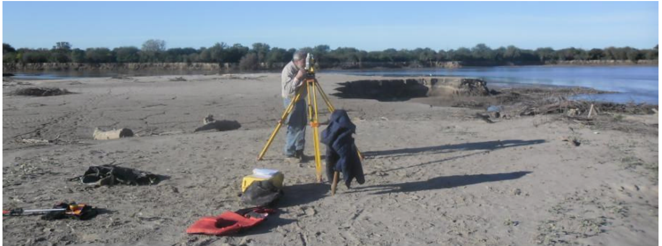
Prog. 2+830 m, margen paraguaya (extremo de península) Vista hacia costa argentina, curva cercana a la ruta.
