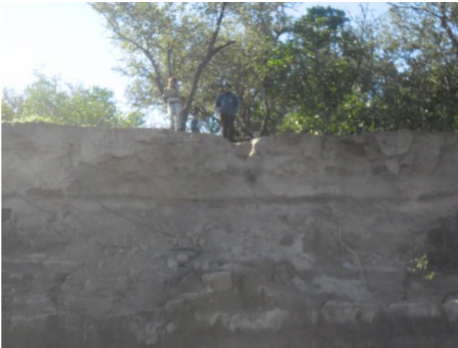
Prog. 0+830 m, margen paraguaya Vista desde el río, barranca de 4,50m de alto.
