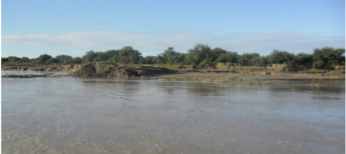
Prog. 1+150 m, margen Paraguaya (terraplén con enramada) Vista desde el río, playa saliente dentro de la curva.
