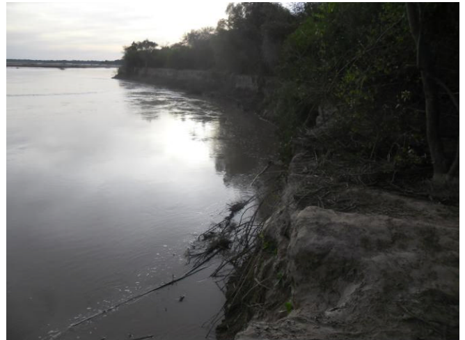
Prog. 2+950 m, margen argentina Vista hacia aguas abajo, barranca de 2,50m de alto.
