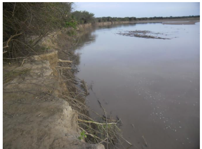
Prog. 2+950 m, margen argentina (curva) Vista hacia aguas arriba.
